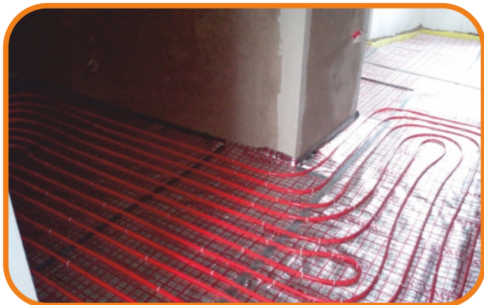
Система тёплого пола с заливкой стяжки
